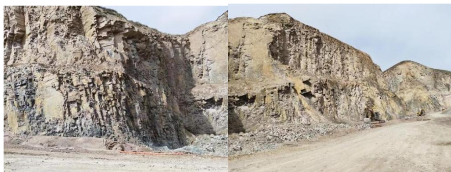
照片 8.2-1 露天采场西边坡及东边坡现状照片
